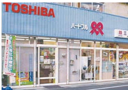
改装前の店舗の様子
