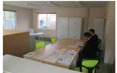
改装工事中の事務所の様子
