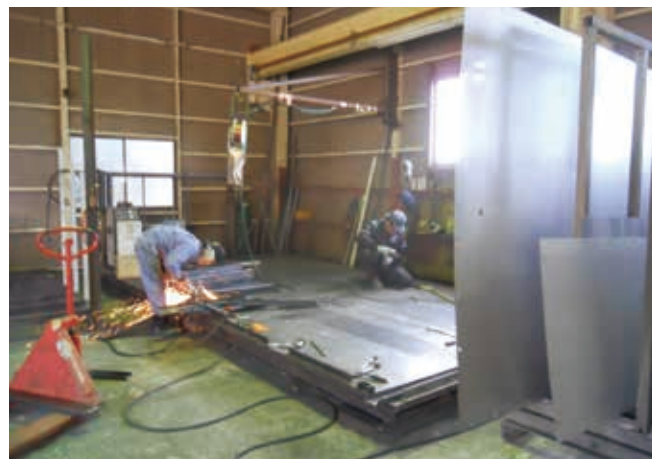
溶接作業中の経営者親子
